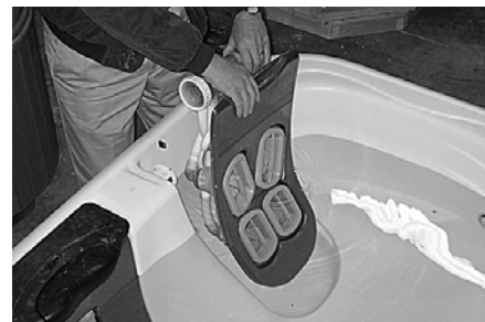
(Figure N) Remove JetPak
